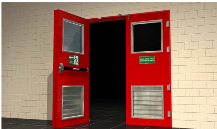
Figura 26 - Compartimentação horizontal através de porta corta-fogo.
