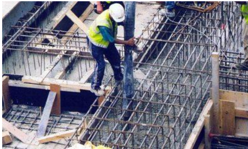
Figura 3 - Preenchimento de fôrmas e armaduras com concreto
