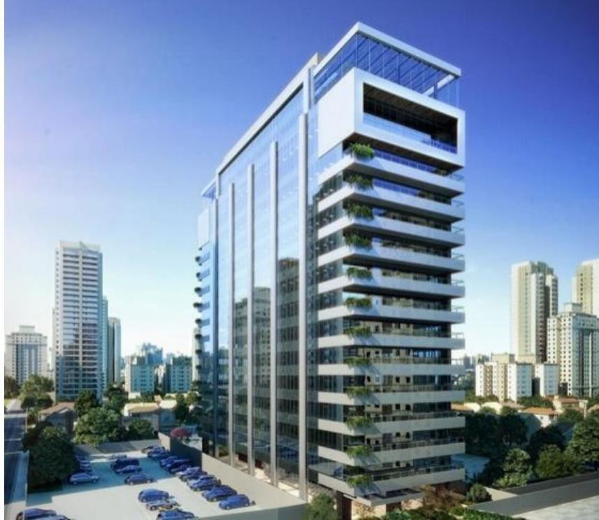
Figura 10 - Edifício The One finalizado – São Paulo
