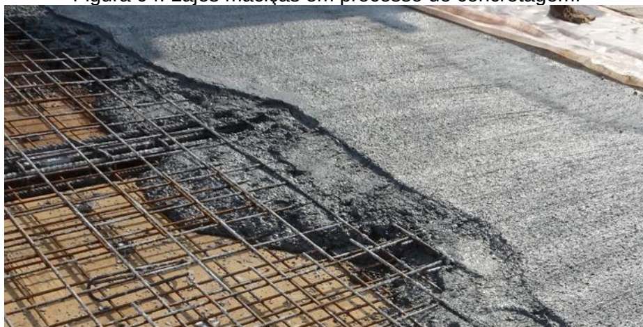
Figura 04: Lajes maciças em processo de concretagem.
