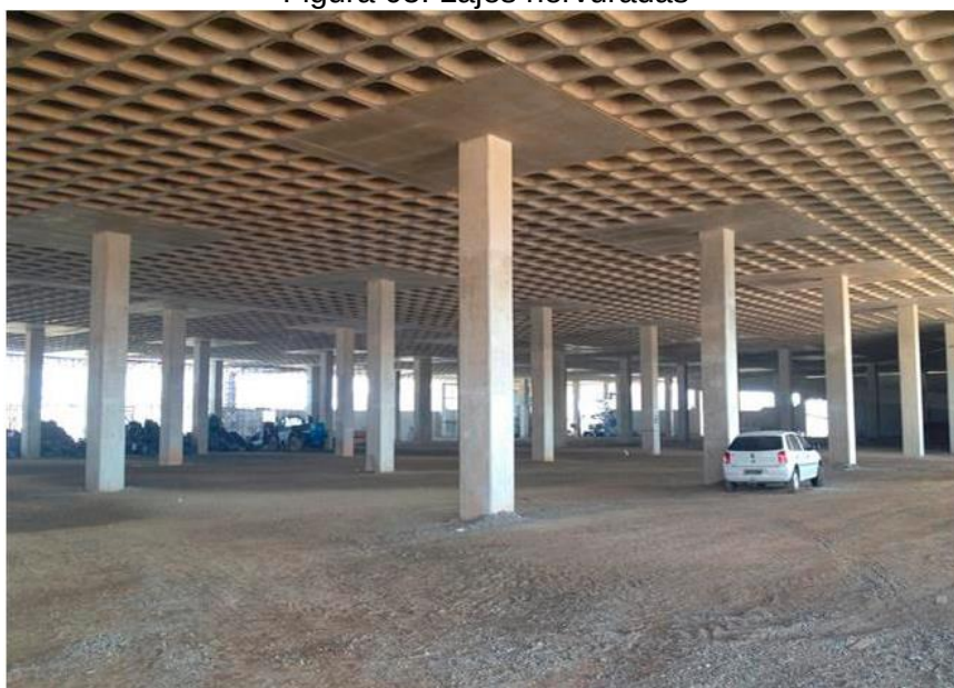
Figura 05: Lajes nervuradas
