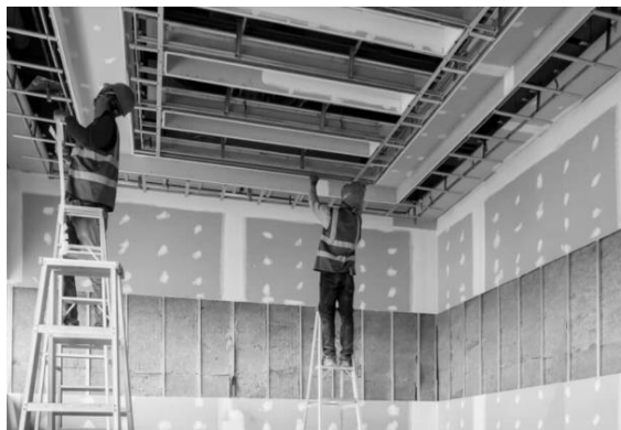
Figura 16: Drywall com Isolamento Acústico
