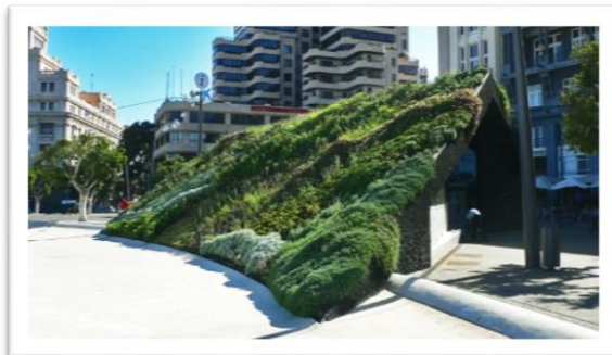
Figura 04 - Telhado Verde
