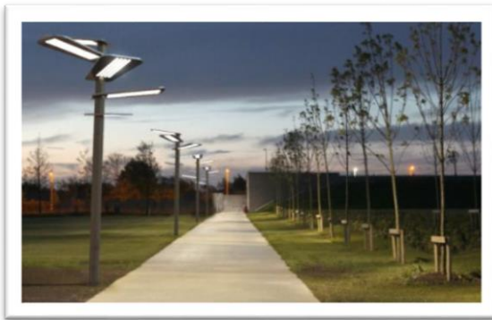
Figuras 87 e 88: Postes Com Placa de Energia Solar
