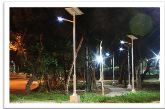
Figuras 87 e 88: Postes Com Placa de Energia Solar
