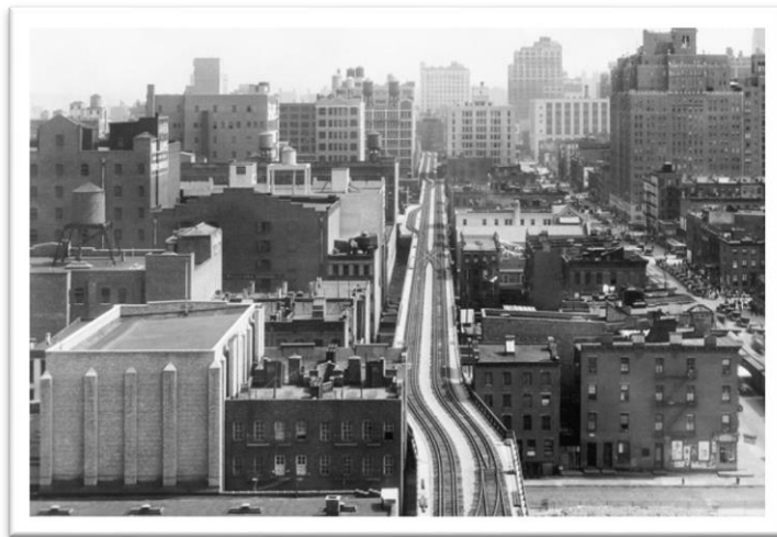
Figura 25 - Vista da linha férrea, de Manhattan, (circa 1934)
