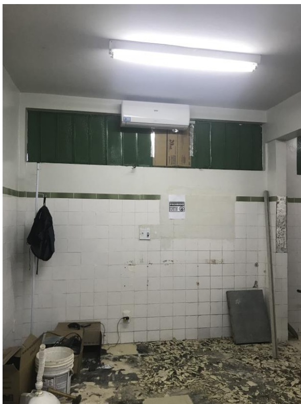
Fig. 33: Consultório pediátrico 02 sendo reformado em 16/10/2018
