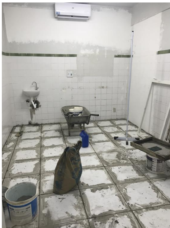
Fig. 34: Consultório pediátrico 02 sendo reformado em 22/10/2018
