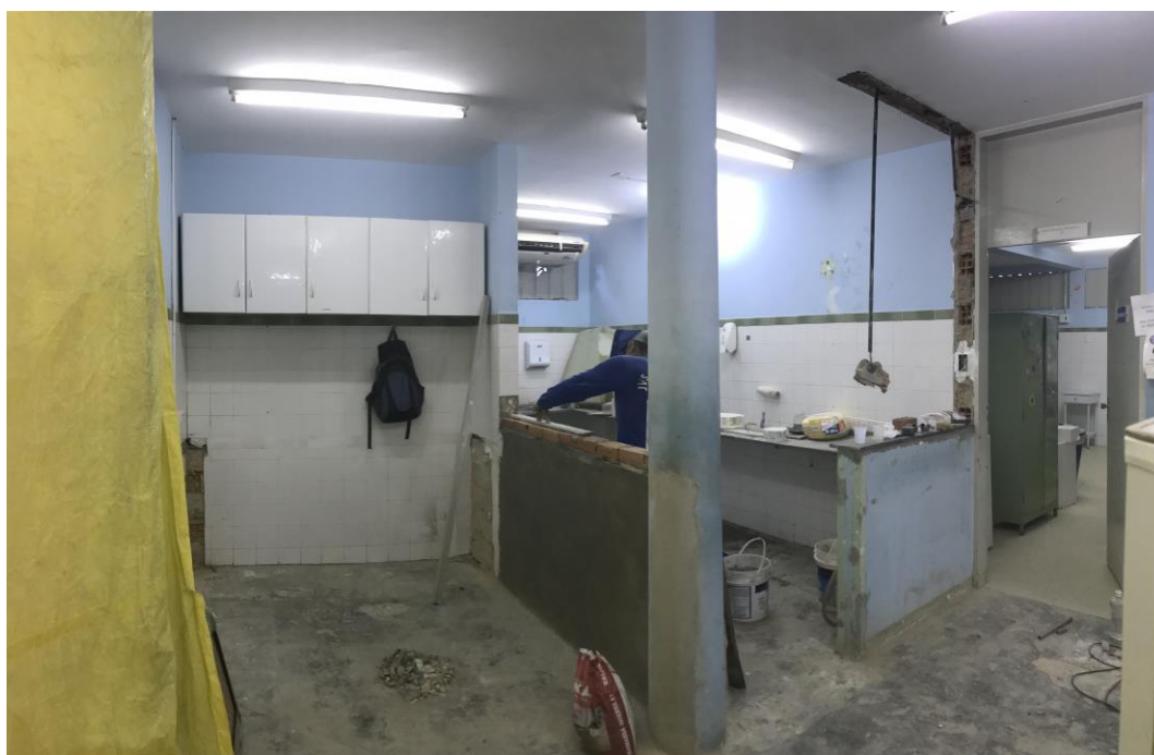
Fig. 36: Criação da brinquedoteca e reforma do posto de enfermagem (visita a obra em 02/11/2018)
