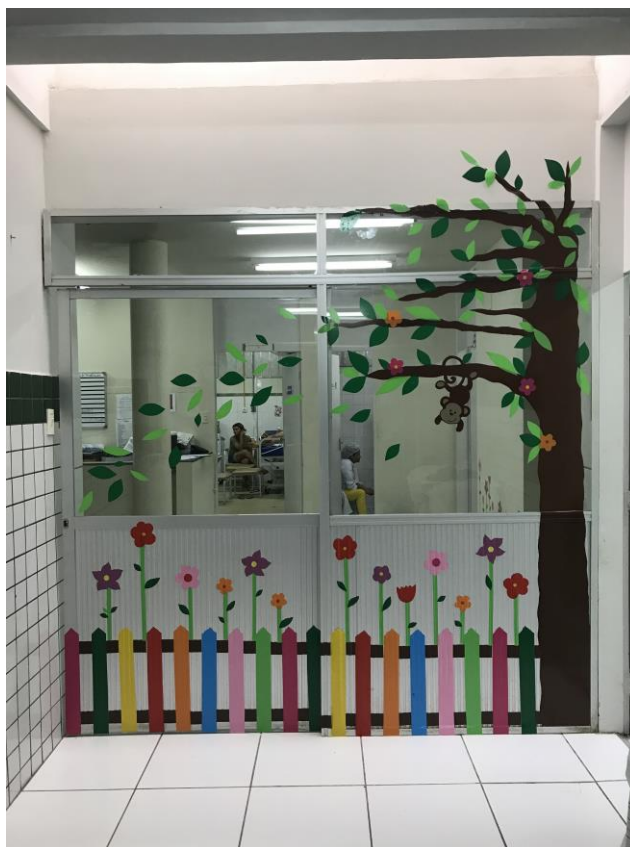
Fig. 46: Porta existente de acesso a internação pediatria, com a nova decoração.
