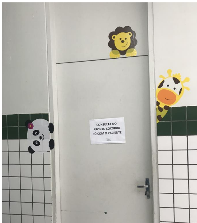
Fig. 49: Detalhe das portas
