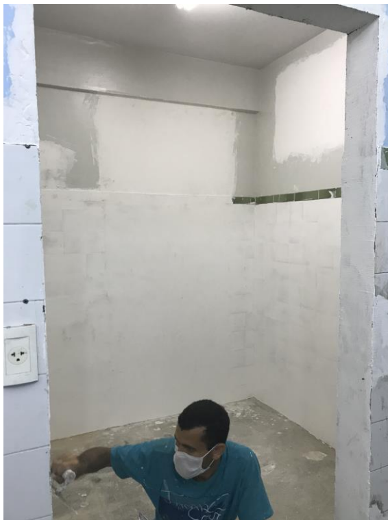
Fig. 37: Criação do espaço de descanso de funcionárias, visita a obra em 02/11/2018
