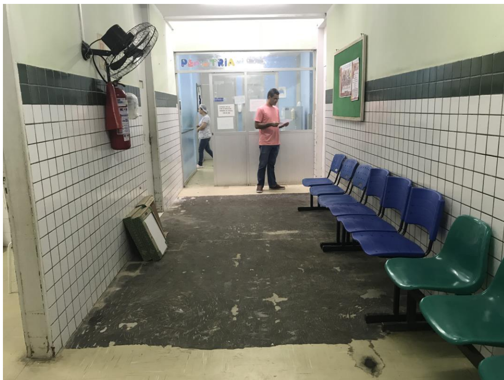
Fig. 35: Espera da pediatria em reforma (troca de piso) em 22/10/2018
