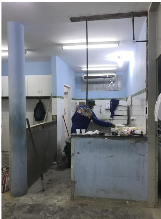
Fig. 38: Reforma do posto de enfermagem pediátrico, visita a obra em 02/11/2018
