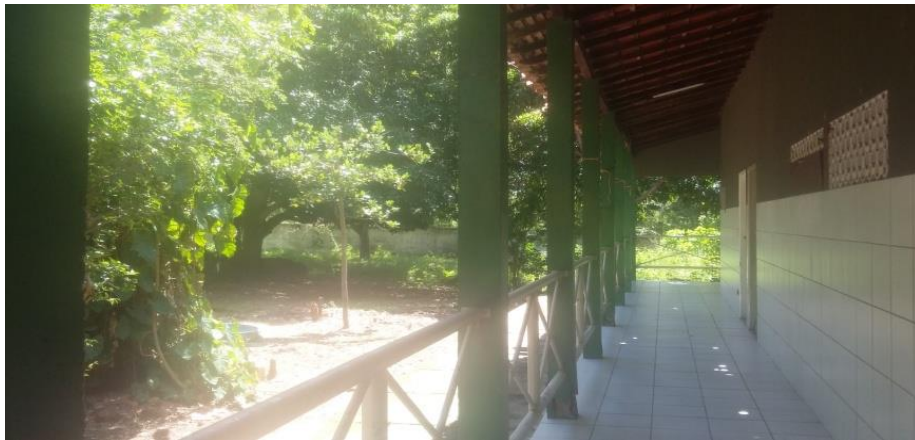
Figura 15 – Área com guarda-corpo em frente aos quartos individuais.
