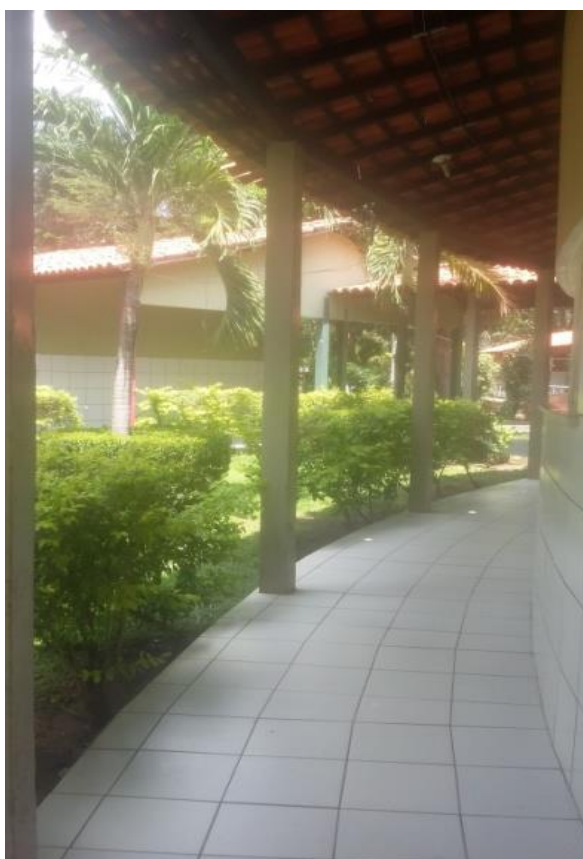
Figura 17 – Piso existente em cerâmica lisa
