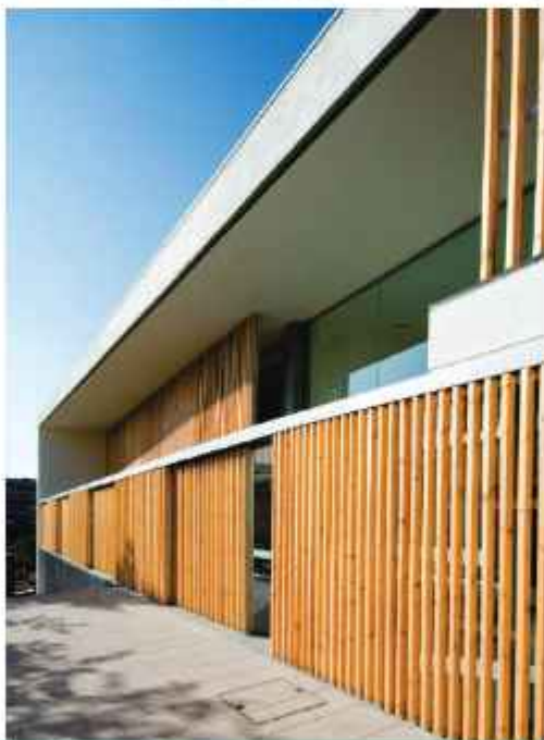
Figura 12: Valorização do brise em sua fachada. Fonte: Archdaily
