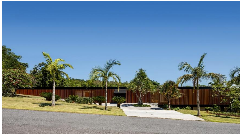
Figura 28 - Fachada Sul Casa 17
