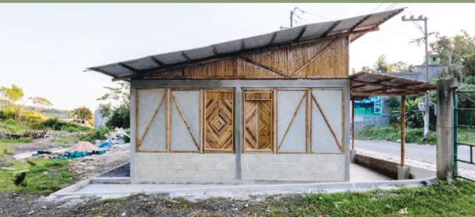
Foto 2: Vista Lateral da Fachada
