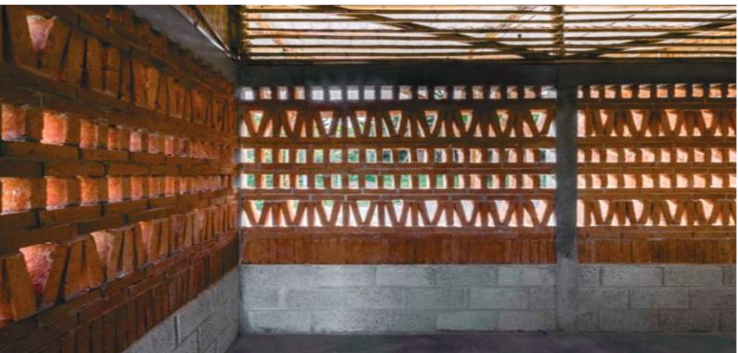
Foto 6: Vista dos Cobogós de Tijolo Maciço
