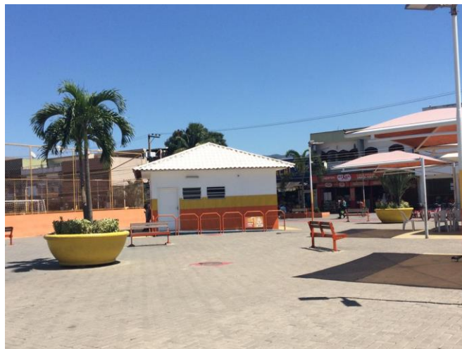
Figura 16 – Banheiros da Praça
