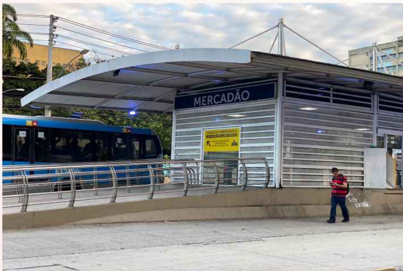
Figura 13: Estação Brt Mercadão
