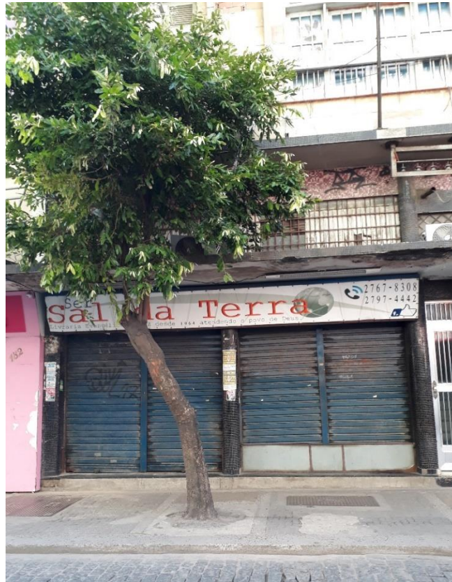
FIGURA 8: Foto 1 (levantamento). fachada de loja.
