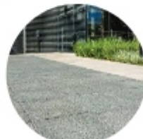
PISO DE CONCRETO
