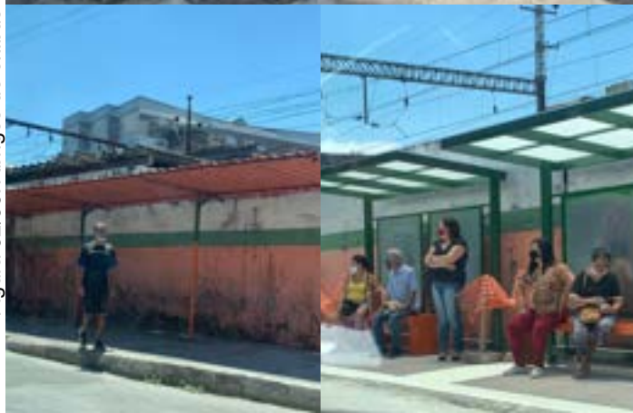
Figura 52/53: Abrigos de ônibus
