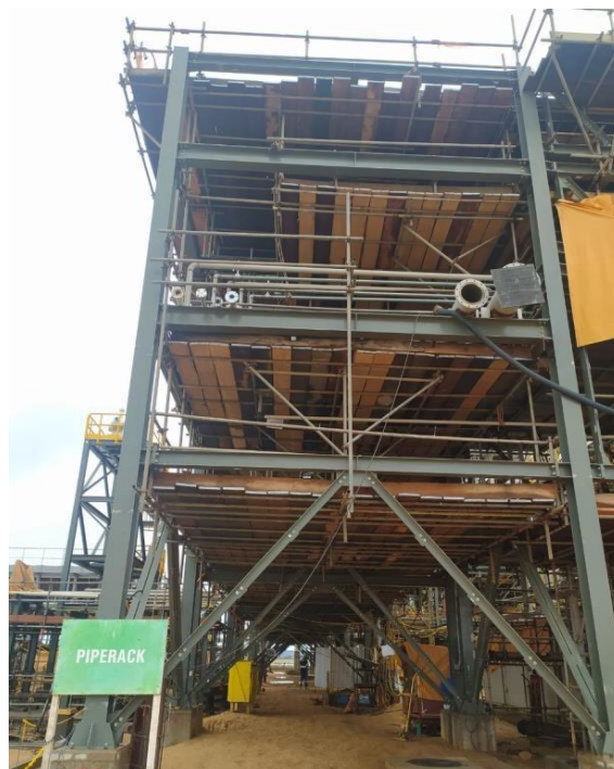
Figura 2: Montagem de tubulaçõesFonte: Autor (2021)
