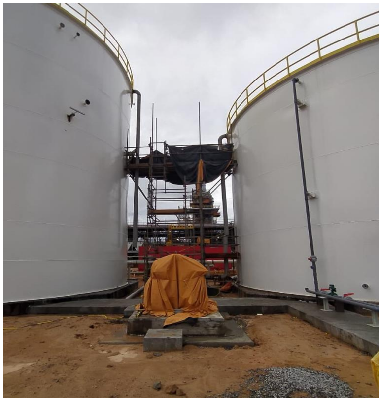
Figura 3: Trabalho em altura nos tanques de águaFonte: Autor (2021)
