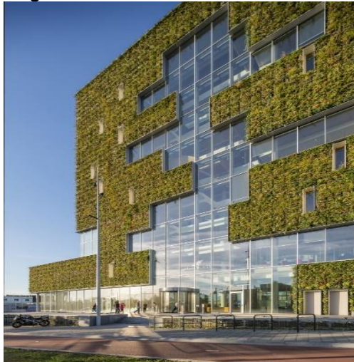
Figura 6: Fachada Stadskantoor Venlo
