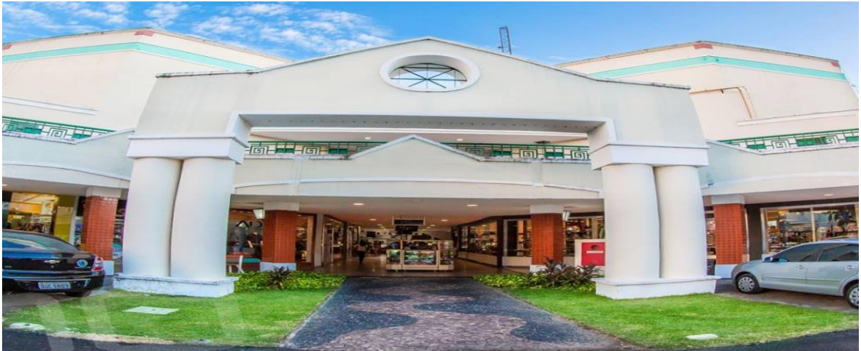
Figura 32: Entrada do Shopping Riverside
