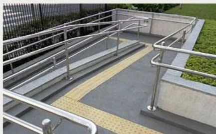
Figura 2: REBAIXO DE PISO Fonte: http://solassist.ufmg.br/telas/solassist/solucoes/solucao.php?id=188
