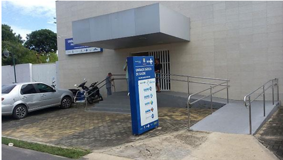
Figura5- Inclinação de calçadas superior à 3% Fonte: Autoria própria (2017)
