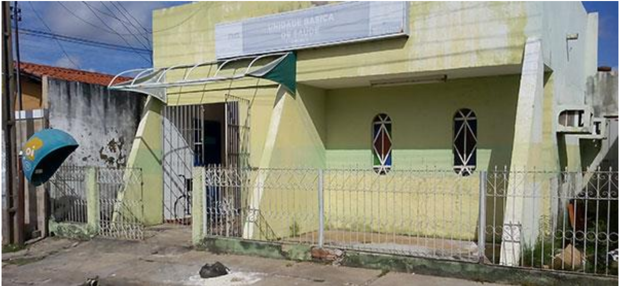
Figura1- UBS instalada em edifício residencial Fonte: Autoria própria (2017)
