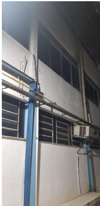
Figura 6: Foto da fachada do bloco L
