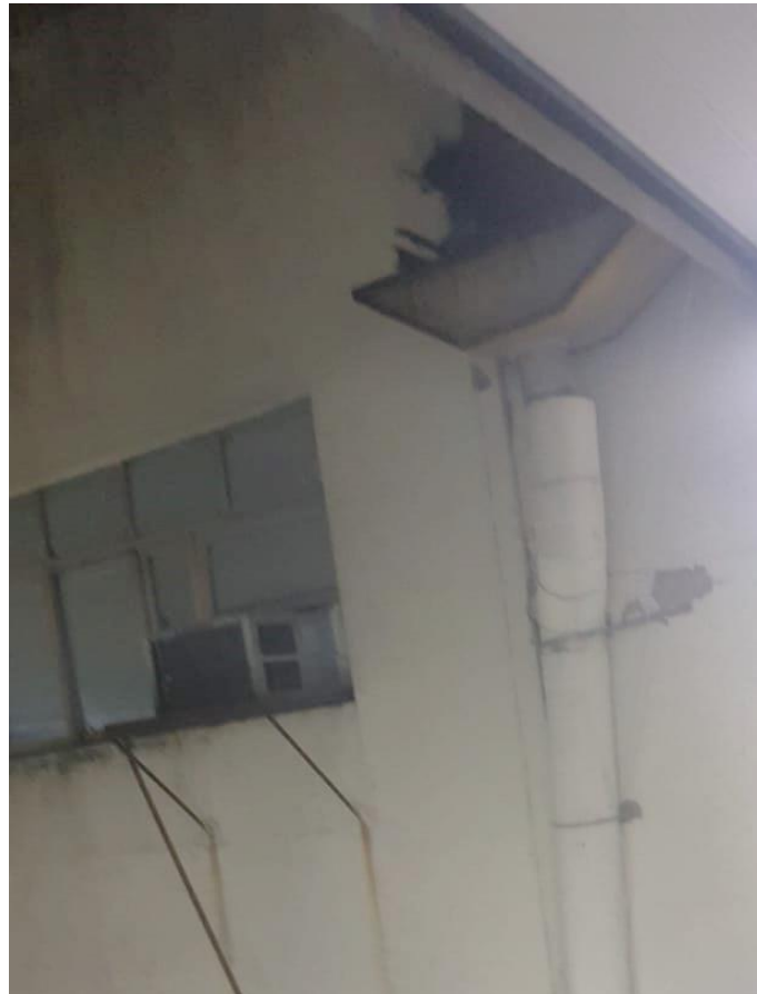
Figura 14: Foto da lateral do bloco – Calha
