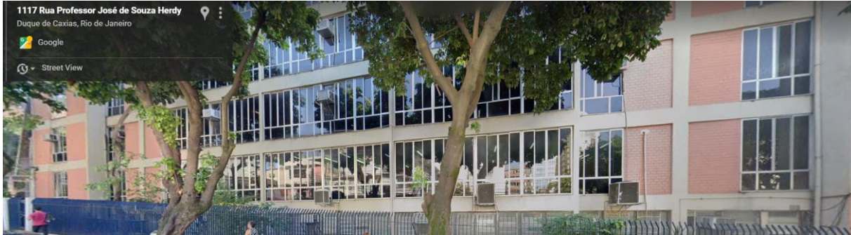
Figura 5: Foto da fachada do bloco secundário
