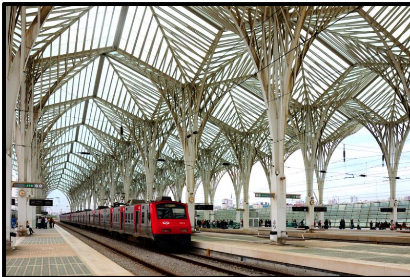
Figura 08: Estrutura da cobertura
