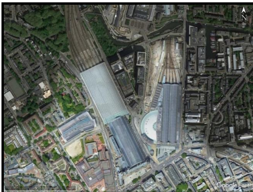
Figura 22: Vista Aérea da Estação King's Cross
