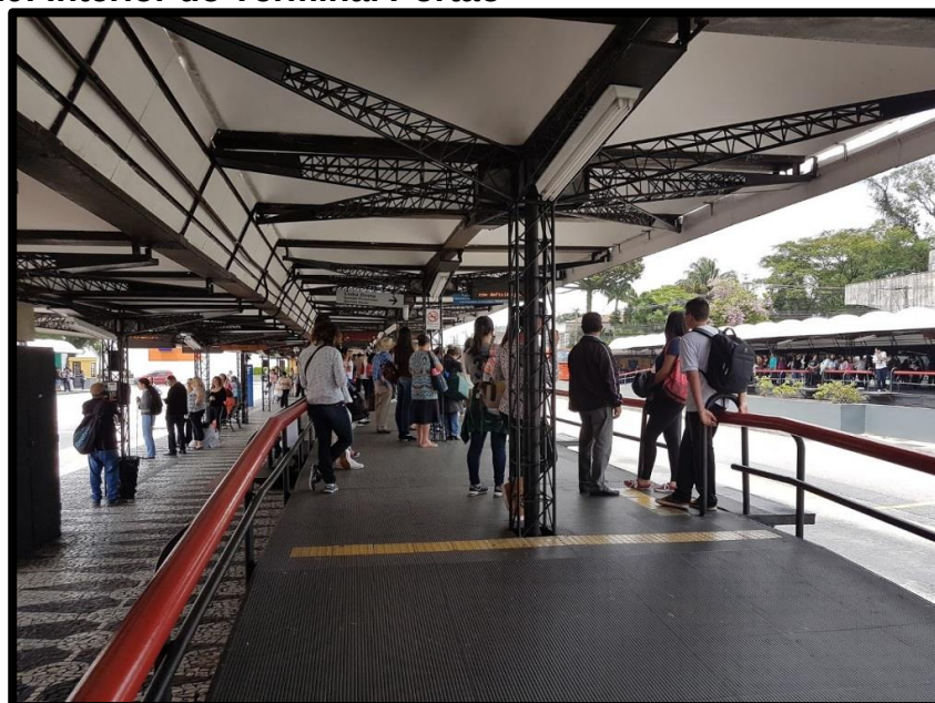
Figura 20: Interior do Terminal Portão
