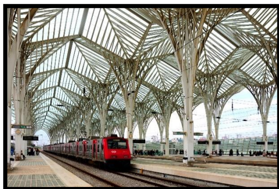
Figura 20: Estrutura da cobertura
