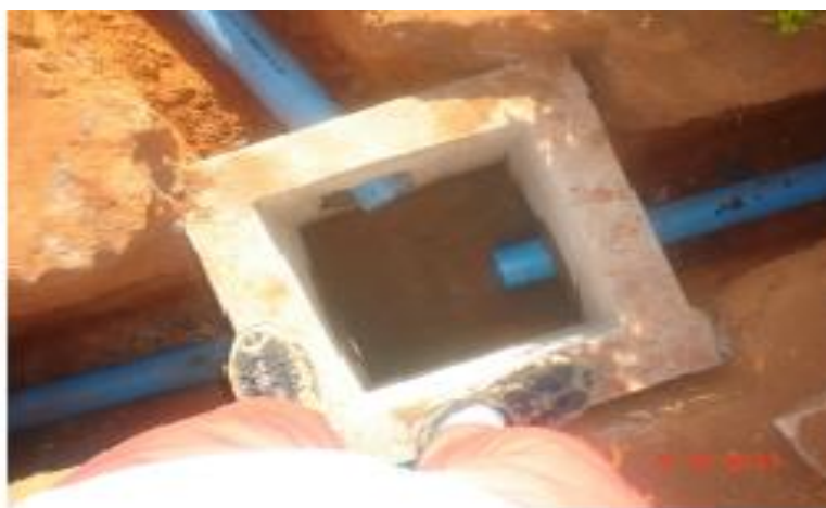
Foto 6: caixa de inspeção ou passagem Fonte: Pereira 2010
