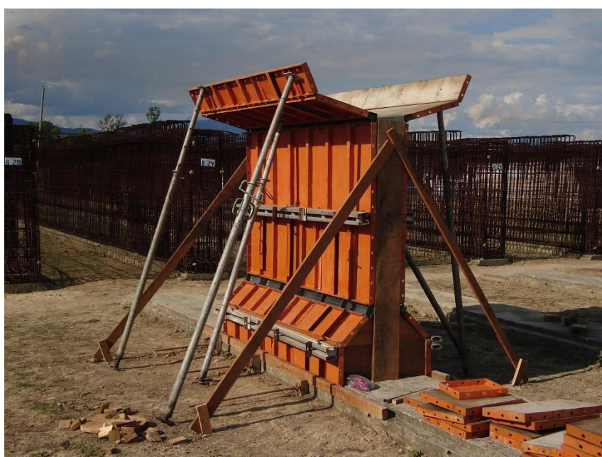
Figura 8 – Viga para Viaduto
