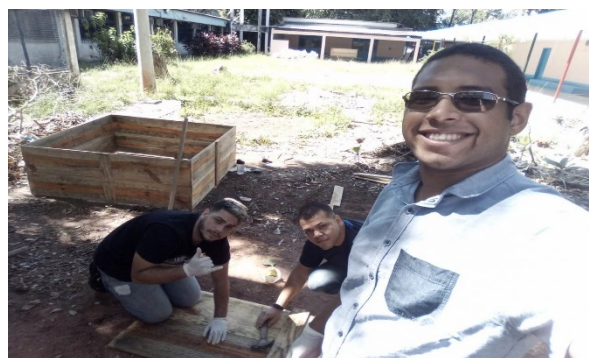
Figura 5. Construção das caixas.
