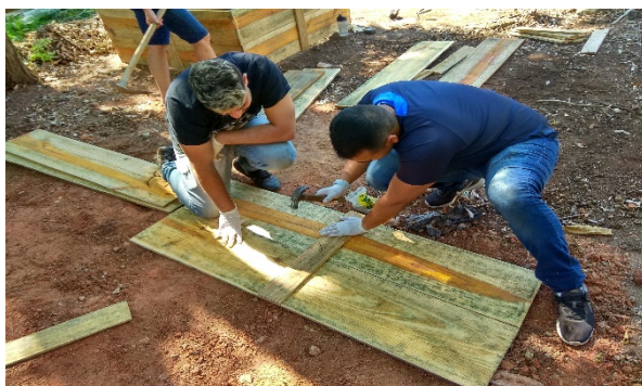
Figura 4. Construção das caixas.
