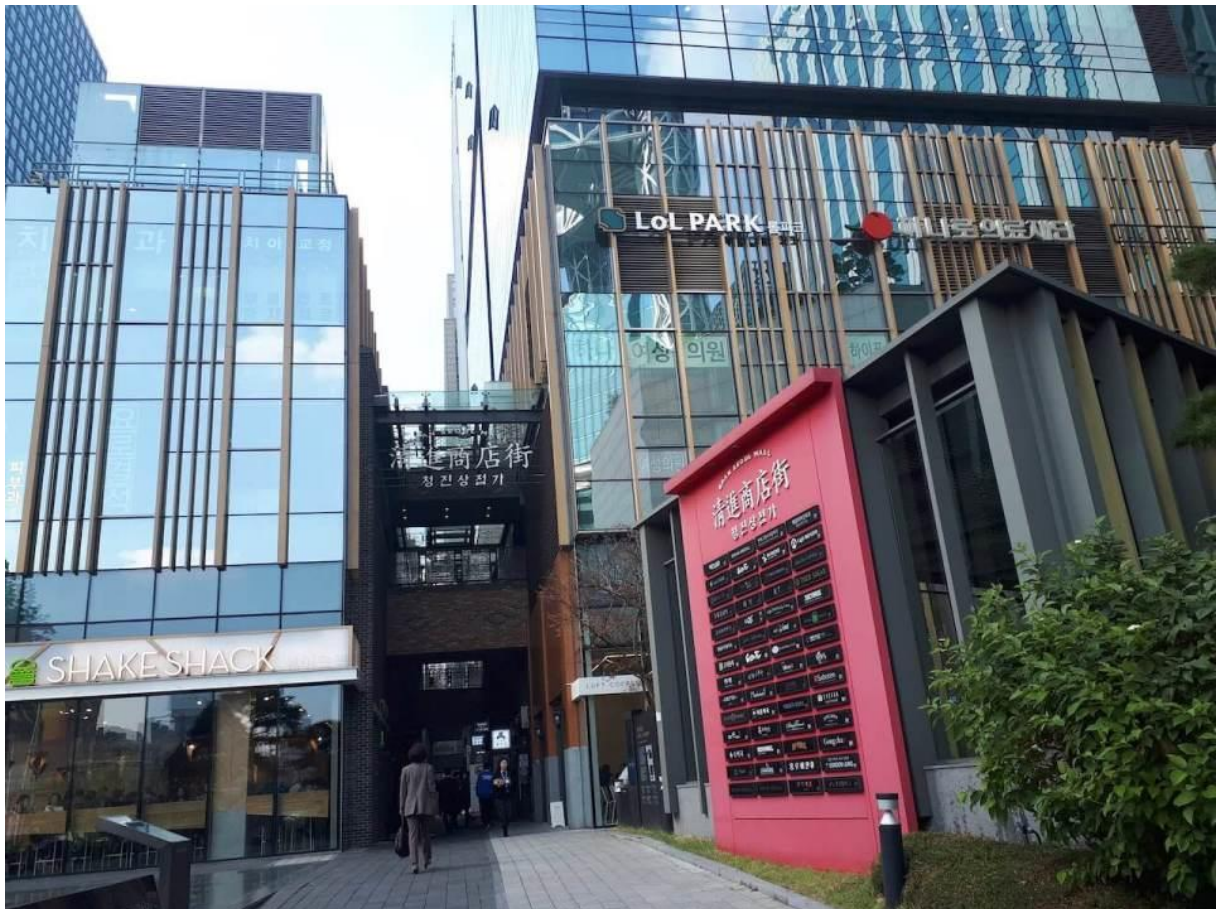
Figura 11: Fachada do edifício
